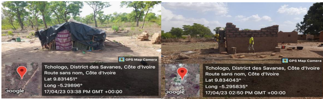
Planche 1 : à gauche, abri de fortune de déplacés burkinabés à l'entrée de Touplevogo et à droite maison en construction pour des déplacés burkinabés
